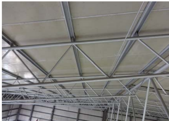
obr. č. 2: krokvičky v krajních částech střechy jsou kolmé k příhradovým vaznicím
